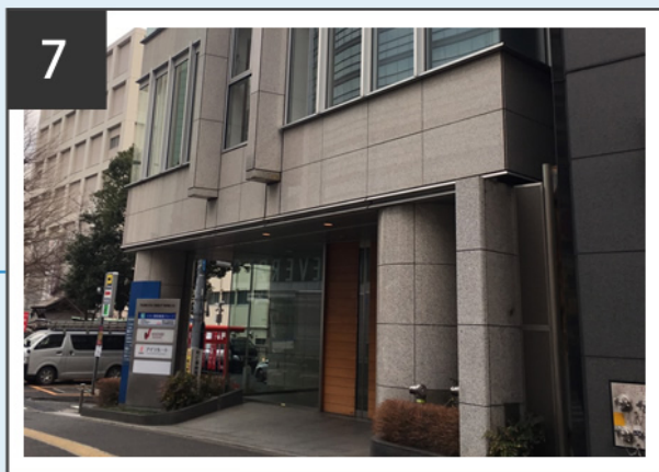
7 ローソンが1階にあるビルの左側が当社ビル
